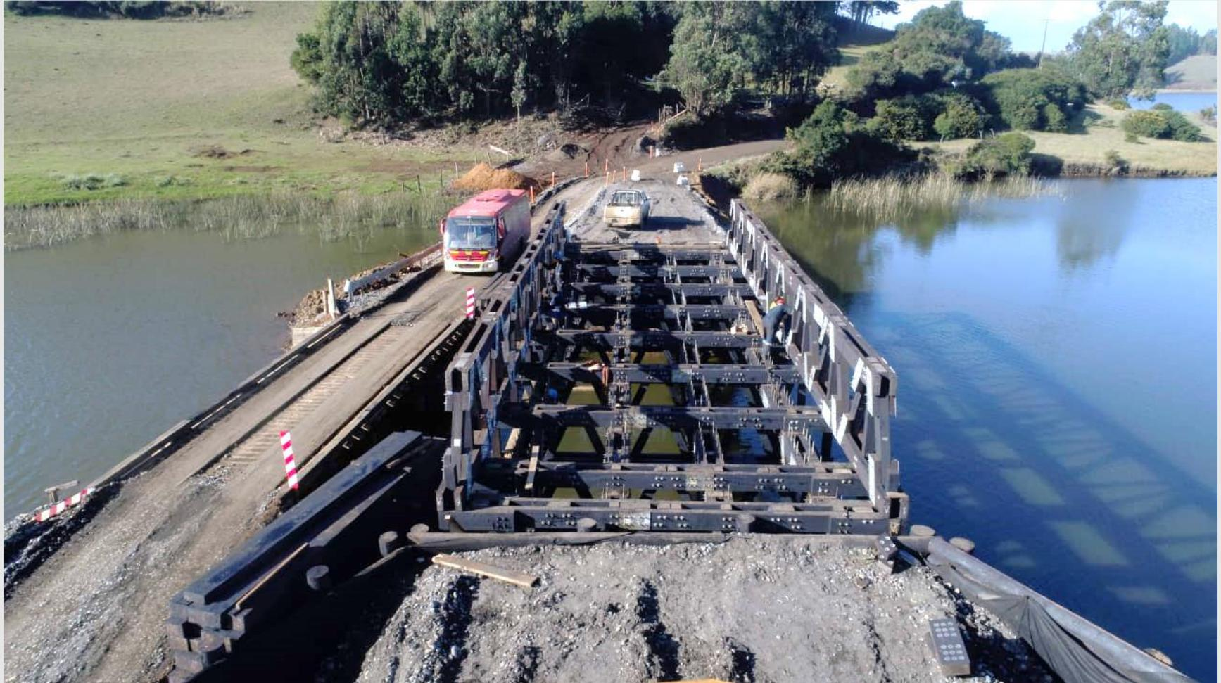
Imagen 13: Esqueleto estructural del puente armado en obra.
