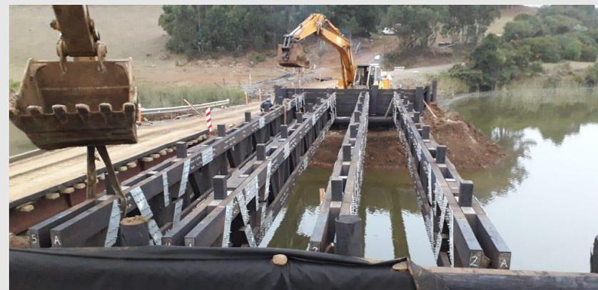
Imagen 11: Montaje de vigas en obra.
