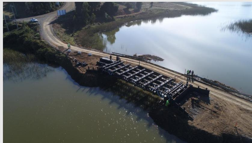
Imagen 12: Vista aérea del armado del puente en obra.
