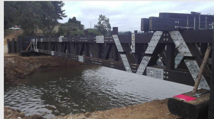
Imagen 9: Montaje de vigas en obra.
