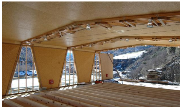
Fig.4.8 Proceso en obra
