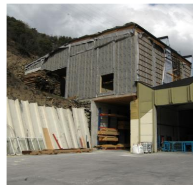
Fig.4.4. Proceso en obra
