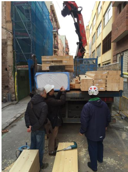
Fig.9.3 Transporte de CLT
