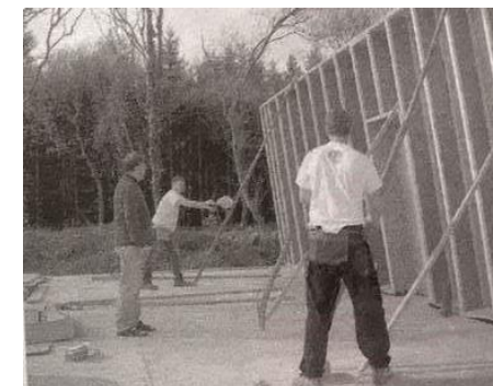
Fig.40 Montaje muro con entramado ligero
