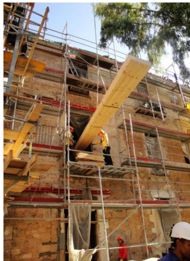
Fig.3.5, 3.6 Proceso constructivo en obra –
