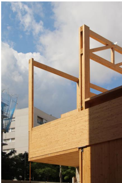
Fig.8.8 Proceso de obra
