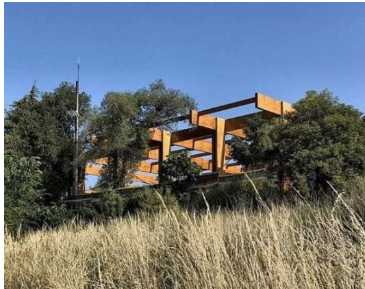
Fig.12.3 Proceso en obra
